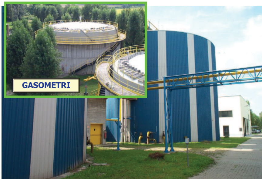
Figura 14: fase di trattamento dei fanghi, depuratore di Robecco sul Naviglio.
