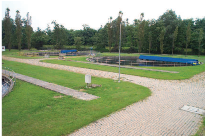
Figura 9: fase di sedimentazione primaria, depuratore di Robecco sul Naviglio.
