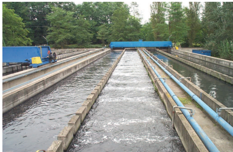
Figura 8: fase di dissabbiatura e di disoleazione, depuratore di Robecco sul Naviglio.
