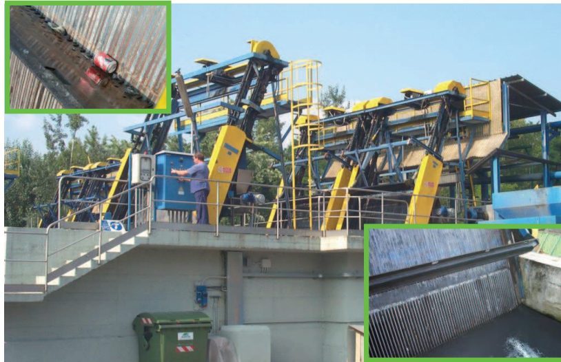
Figura 7: fase di grigliatura, depuratore di Robecco sul Naviglio.
