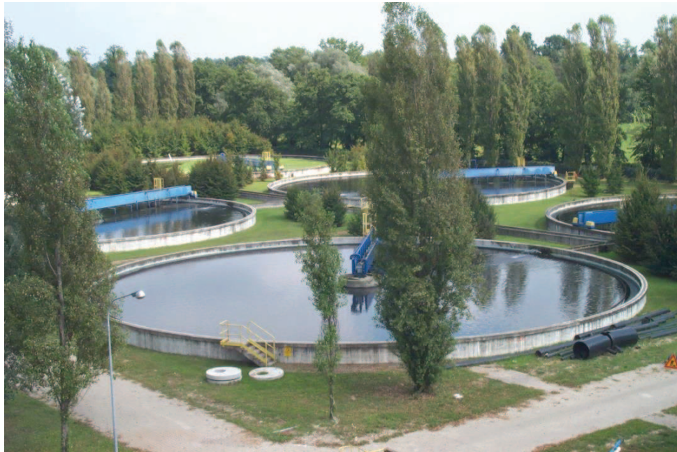
Figura 12: fase di sedimentazione finale, depuratore di Robecco sul Naviglio.
