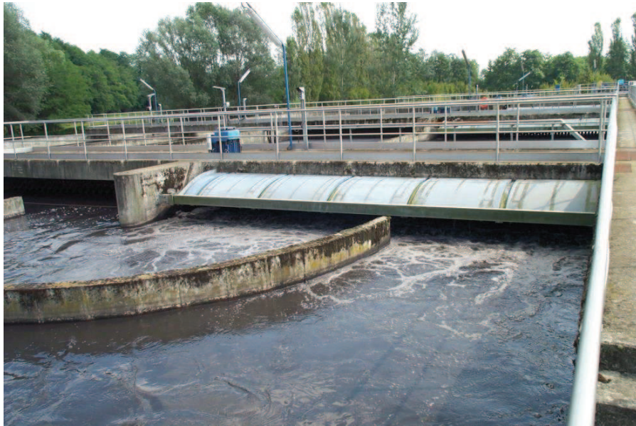
Figura 10: fase di ossidazione biologica, depuratore di Robecco sul Naviglio.
